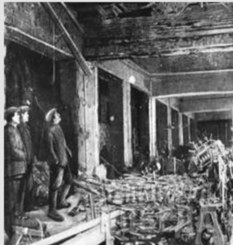
Разрушенный цех завода
